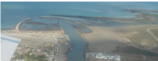
Figura 4: Obra Remodelación Pto. Rawson (2001-2005). Se puede ver la construcción de escolleras, Muelle Nuevo Pesquero y Dragado del canal de acceso. (Fuente: Dirección de Infraestructura Portuaria).
