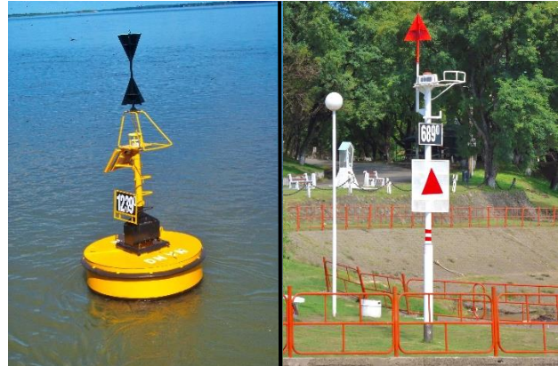
Figura 3: Balizamiento actual Diurno / Nocturno Cardinal Oeste en Confluencia, Baliza de Estribor en Hernandarias
