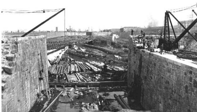
Figura 2: (Construcción de los diques de Puerto Madero)
