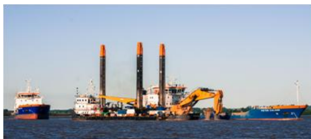
Figura 10. Vista de los equipos a cargo del dragado de rectificación
