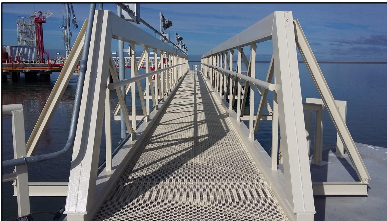
Figura 5 - Pasarelas de vinculación
