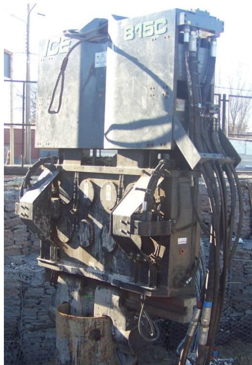
Figura 4: Cabezal vibrohincador colocado sobre una camisa metálica (registro propio)
