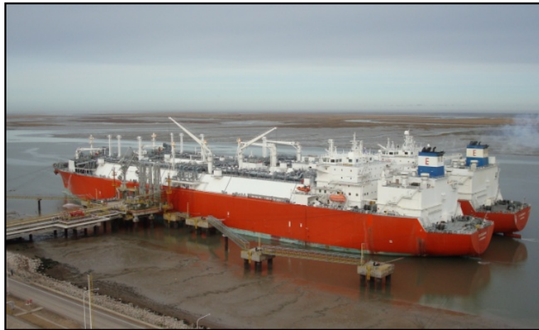
Figura 1. Terminal de LNG Mega (Bahía Blanca)
