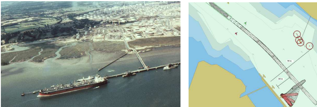
Fig 6. Terminal de combustibles en el Reino Unido.
