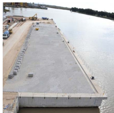
Foto 21 – Pavimento Bloques intertrabados
