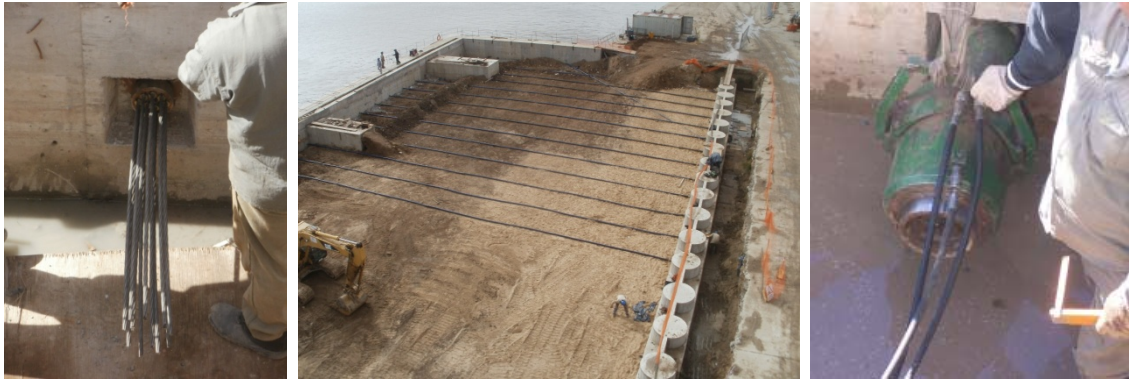
Fotos 13-14 y 15 – Cabezal de tensor, Tensores, Tesado
