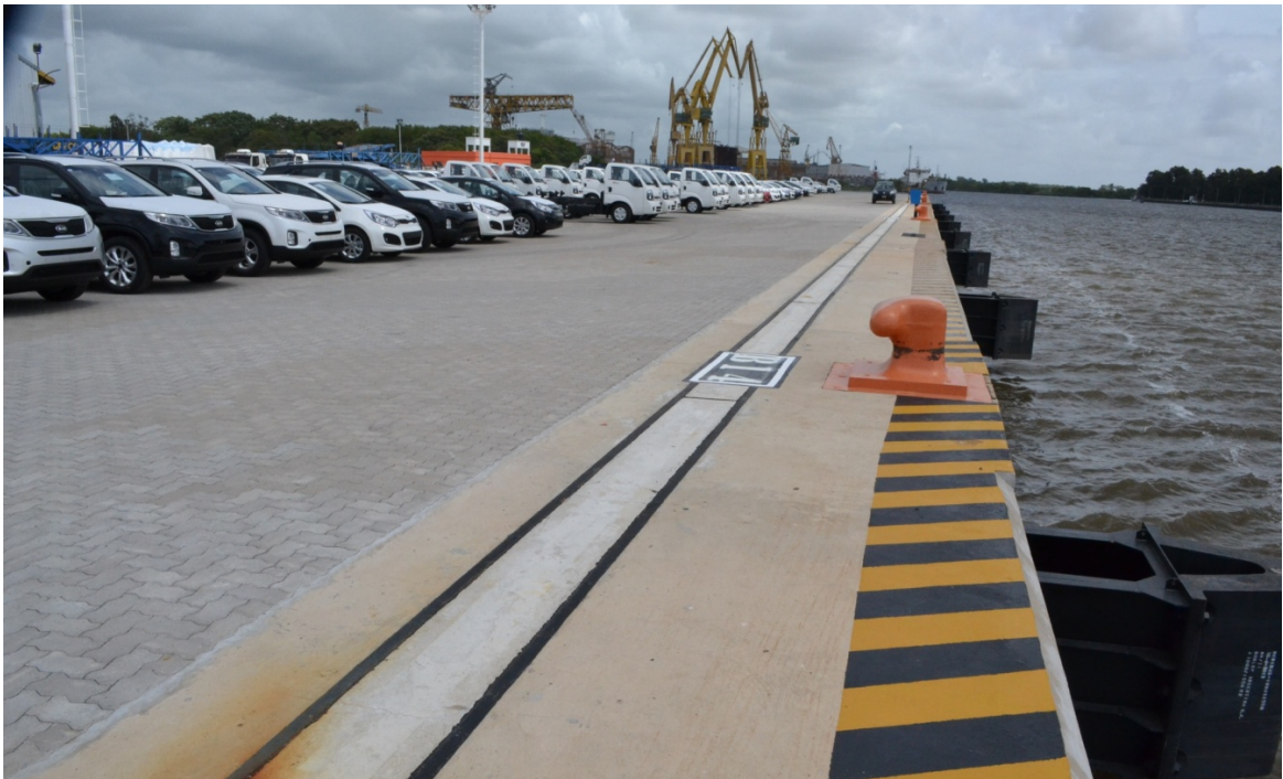
Foto 24 – Obra finalizada. Noviembre 2013
