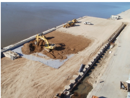
Foto 20 – Construcción estructura soporte del pavimento
