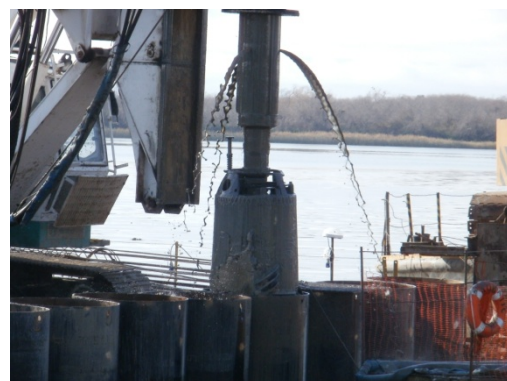
Foto 10 – Excavación de pilotes
