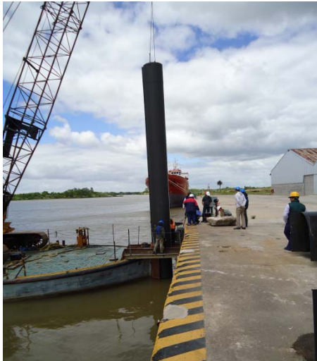
Foto 7 – Inicio de obra
