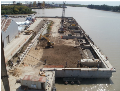
Foto 16 – Viga coronamiento, cabezales, viga de retenida
