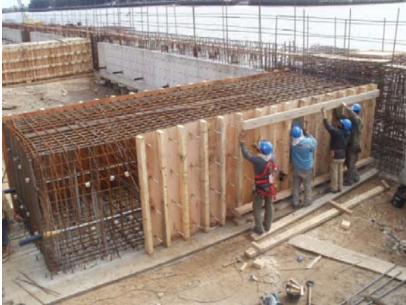
Foto 11 – Armadura y encofrado de cabezales
