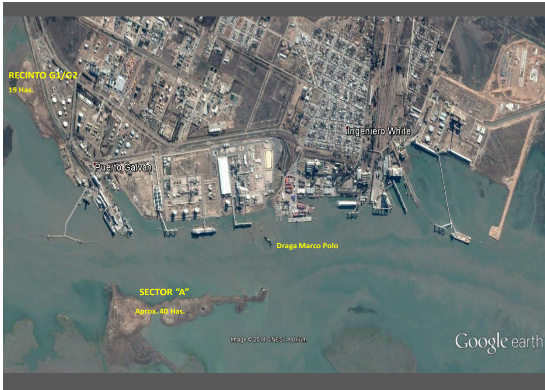
Fig. 16 – Estado final de los rellenos en el Recinto G1 y el Sector A
