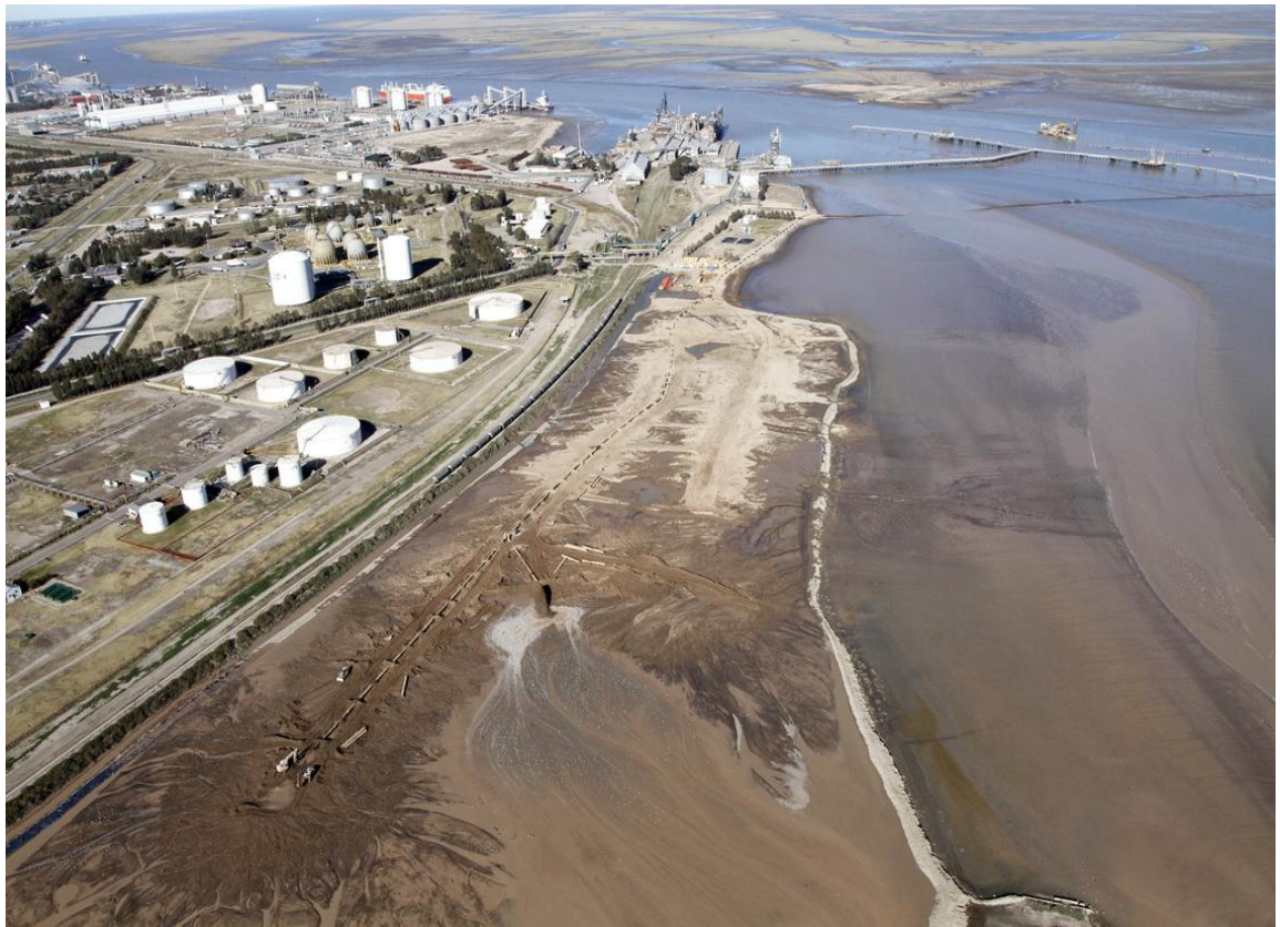
Fig. 14 – Trabajos de relleno del recinto G1
