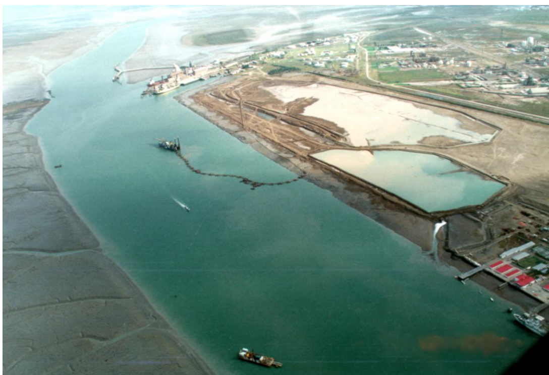
Fig. 2 – Operativo de dragado contratado por el Estado Nacional - 1990
