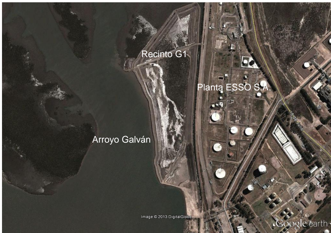
Fig. 13 – Recinto G1 para relleno mediante refulado del material dragado
