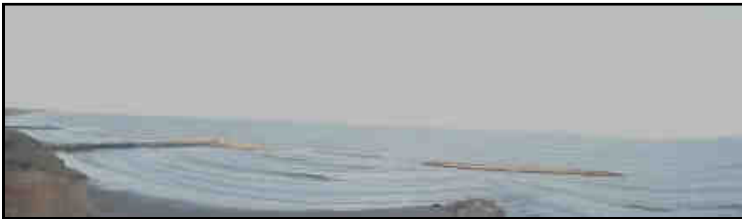
Fotografía N°5: Difracción del oleaje por los rompeolas construidos.
