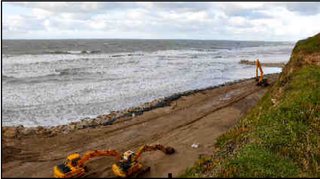
Fotografía N°3: ejecución de la protección al pie de acantilado
