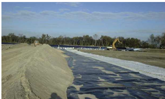
Preparación del depósito
